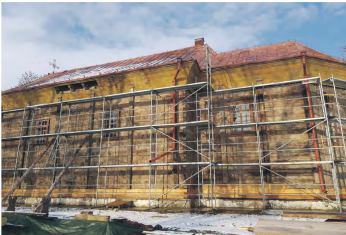
Remont kościoła - widok z zewnątrz (fot.: Parafia Dub)
