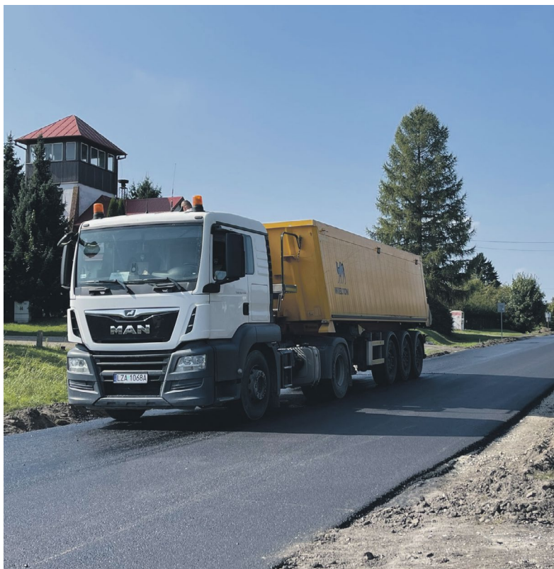
Rozpoczęcie przebudowy drogi Skierbieszów - Hrubieszów na odcinku w miejscowości Obrowiec (fot.: arch. Starostwa Powiatowego w Hrubieszowie)
