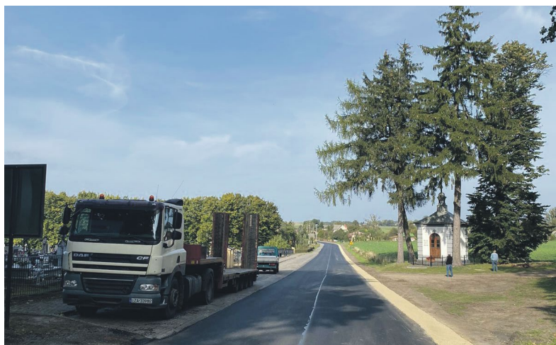
Remont drogi na odcinku Kopyłów - Szpikolasy w miejscowości Szpikolasy (fot.: arch. Starostwa Powiatowego w Hrubieszowie)
