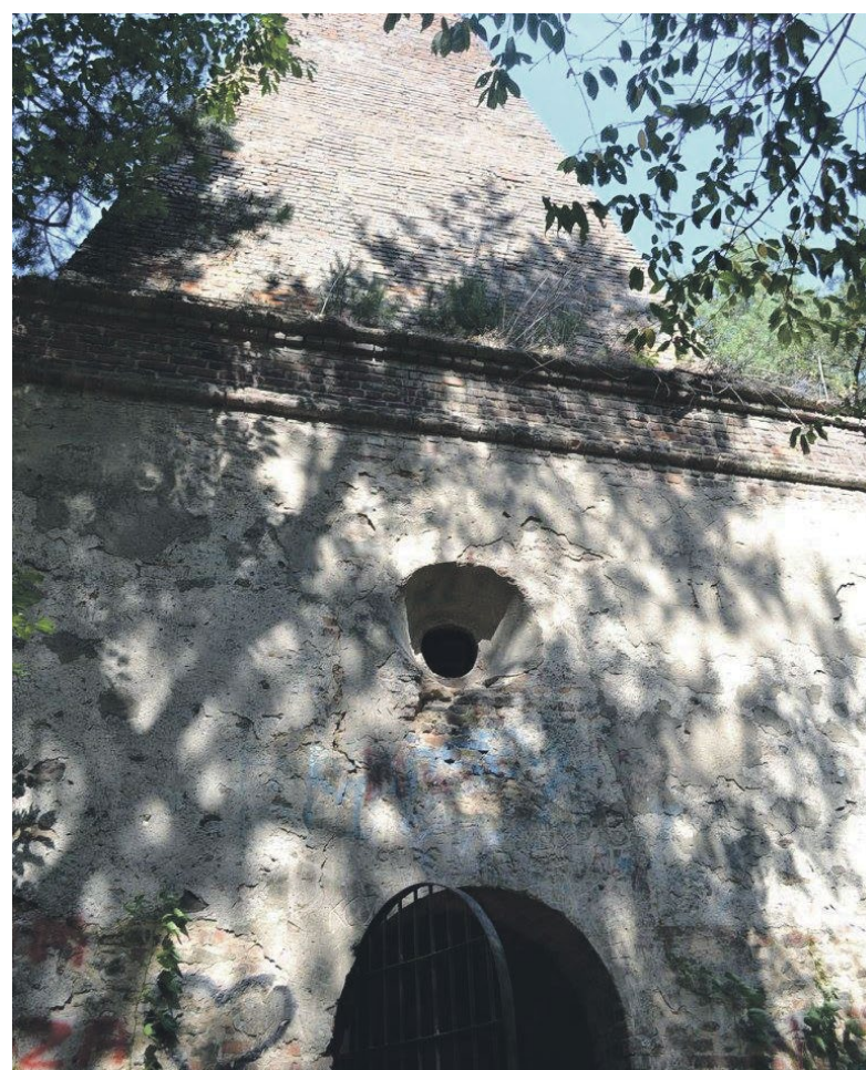
Wieża Ariańska przed remontem (fot.: Ł. Kot)
